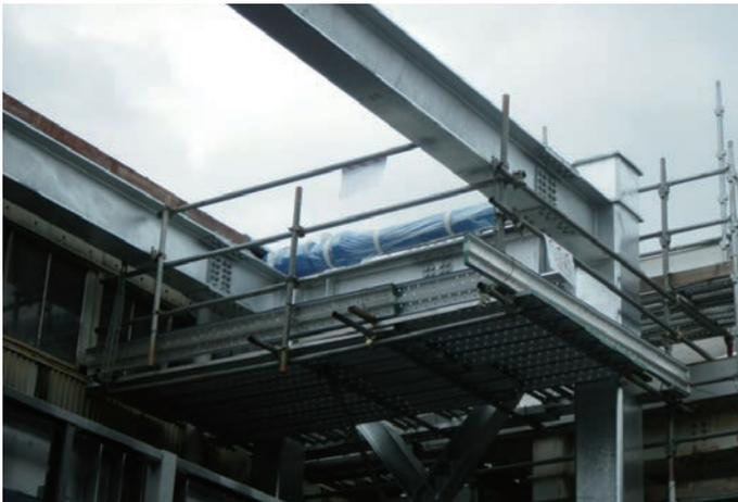
▲工場外部での制震補強工事の様子。工場内部では操業が続けられていた。
