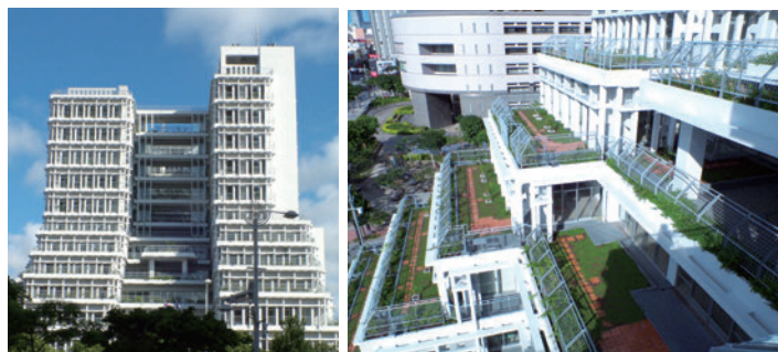
2013年1月に竣工した那覇市新庁舎 緑を豊富に取り入れたデザイン
