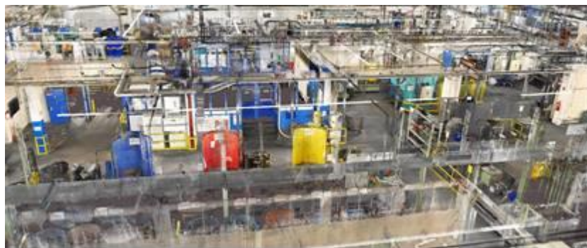
VLXにて計測した工場内部の点群データ
