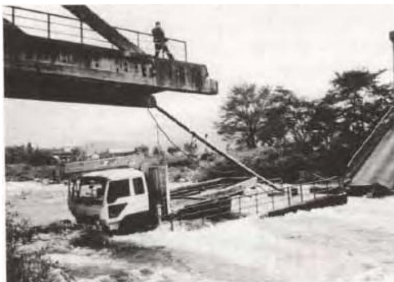
岐阜県 町道 下田瀬1号島田橋 1990落橋 PC鋼線腐食
