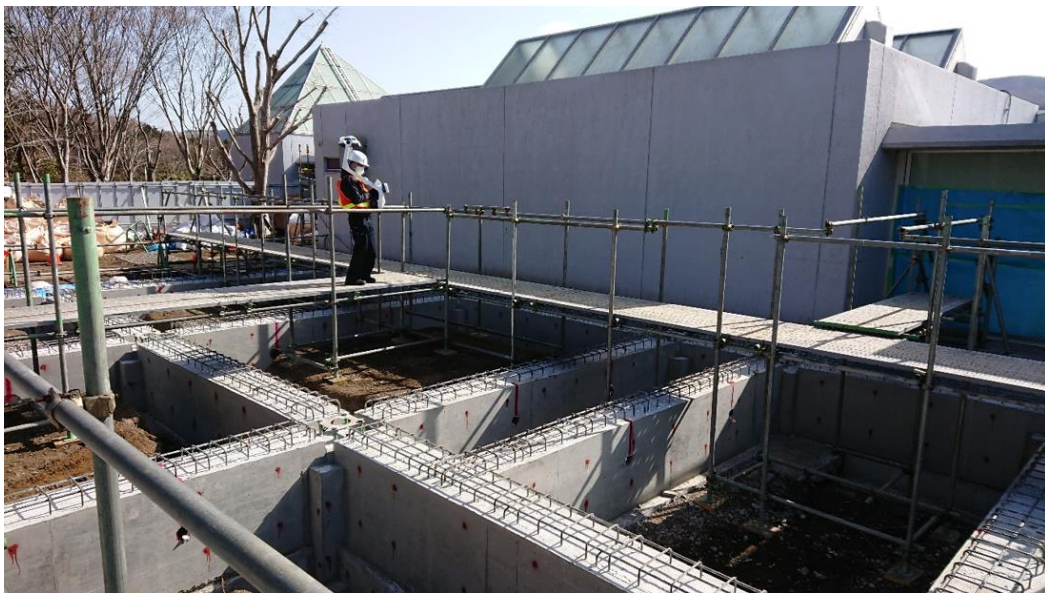
基礎工事現場における計測の様子
