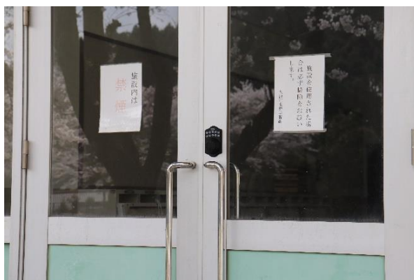
町内の野外活動等研修センター入り口に設置された「RemoteLOCK」
