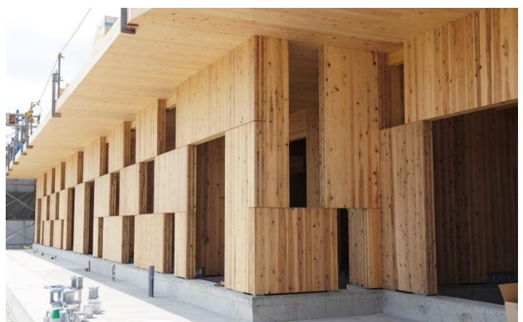
CLT市松ブロック壁を取り入れた 「平成学園ひまわり幼稚園」
