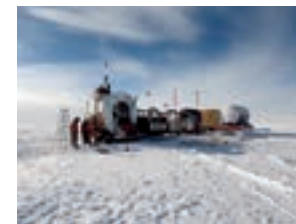
ARA建設時の掘削風景(引用: ARA公式サイト)
