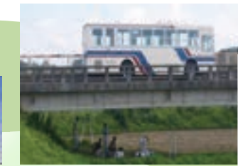
橋梁モニタリングシステム
